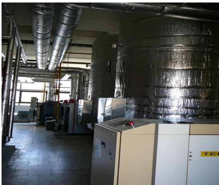
Kotelna s kogenerační jednotkou v popředí.
