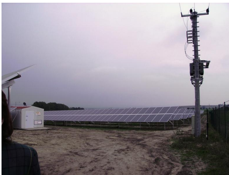
Řada fotovoltaických panelů s trafostanicí
